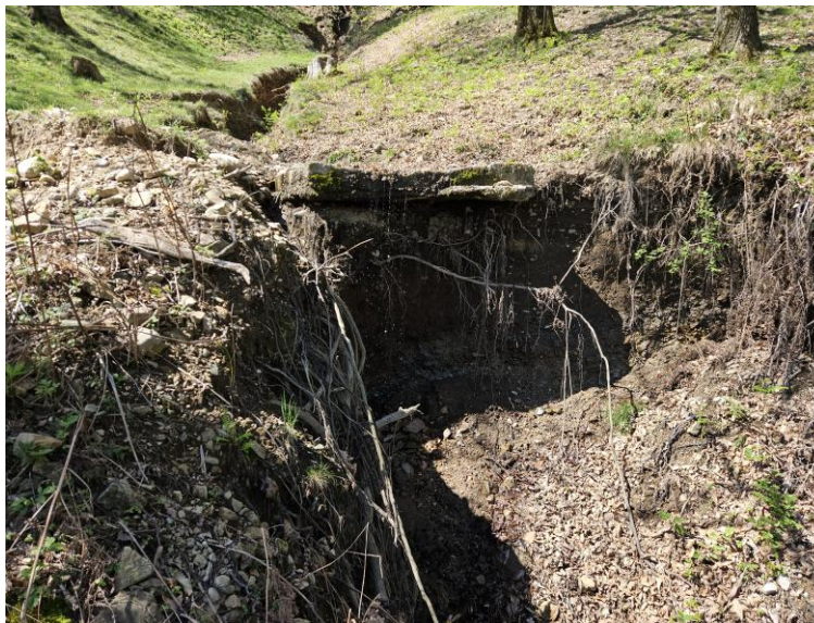
Foto 1 e 2: tratto di pista dove c'è il travaccone e l'importante erosione al piede
