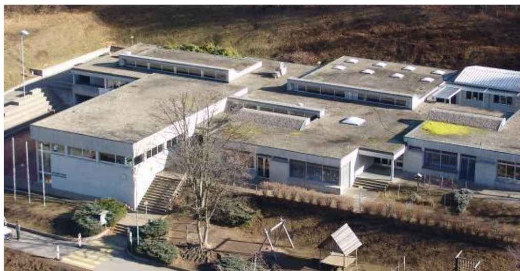
Centro scolastico Alto Malcantone, Scuola elementare
